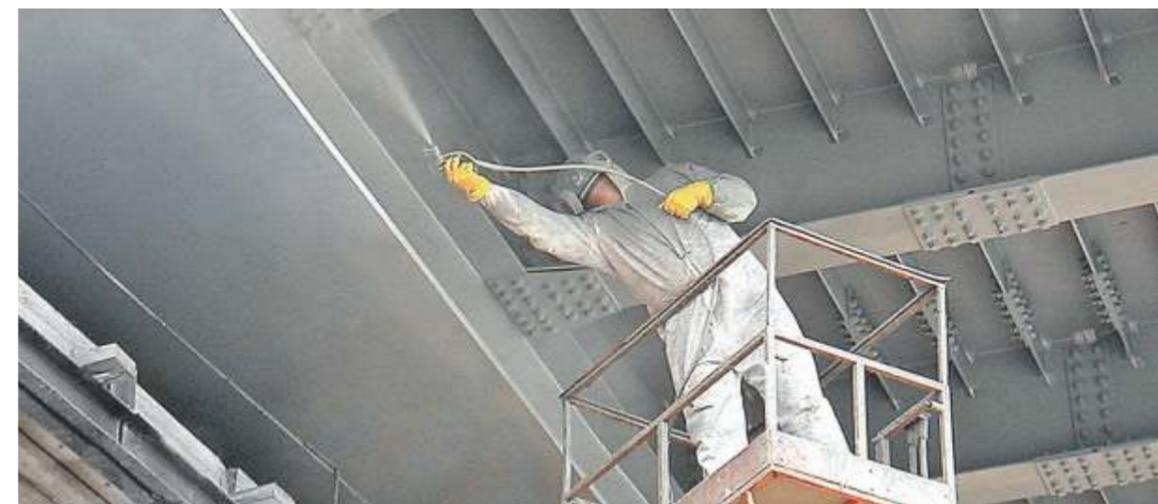
Окраска металлоконструкции материалами ВМП методом распыления
