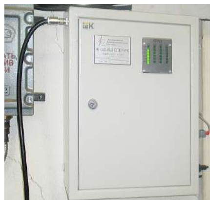
Пример размещения Шкафа КШ в здании ГРС
