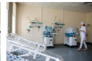
Оснащение помещений «под ключ»
