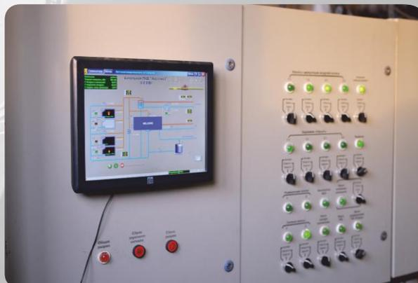
Система автоматики построена на основе контролера ACS 303 и может подключаться к централизованному диспетчерскому пульта. Управление котельной автоматикой осуществляется программным обеспечением (ПО), построенным на базе OPC сервера. Комплект оборудования может быть спроектирован и выполнен по индивидуальным требованиям заказчика.
